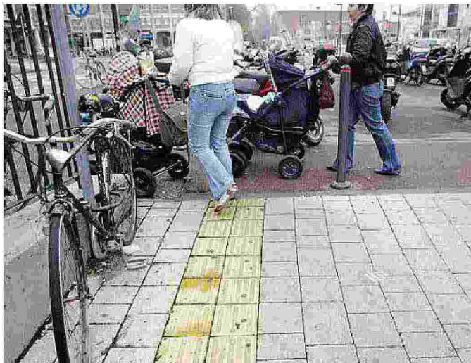
Un percorso per non vedenti interrotto in piazzale Marconi
